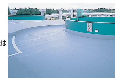
UPV-SE工法 (露出ウレタンFRP防水仕様) …スロープ
