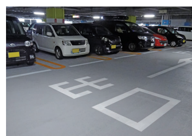
MU-1E工法、UH-1E工法 …中層階・地下駐車場
