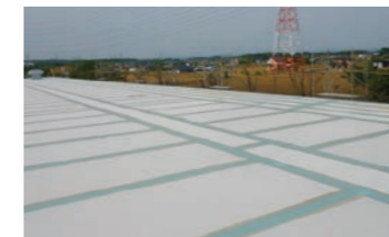
ジョイント補強増し塗り
