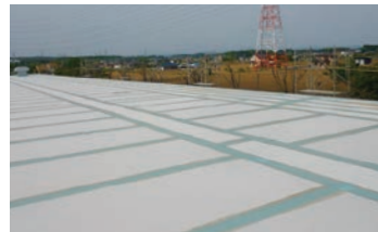
ジョイント補強増し塗り
