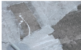
プライマー塗布
