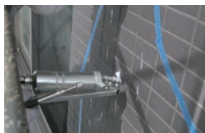
タイル張付けモルタルと躯体間の浮き部注入 欠損部のプライマー用途 (SK モルタル)
