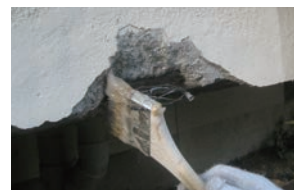
タイル張付けモルタルと躯体間の浮き部注入 欠損部のプライマー用途 (SK モルタル)
