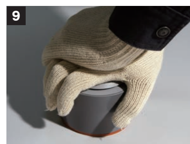
専用圧着治具で約8～10秒押える
