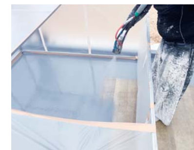
スプレー吹付状況
