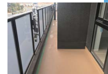
超速硬化スプレーウレタン吹付後
