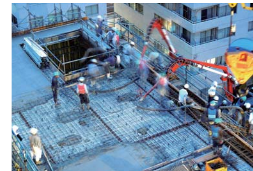
保護コンクリート打設の削減提案
