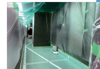
超速硬化スプレーウレタン吹付養生
