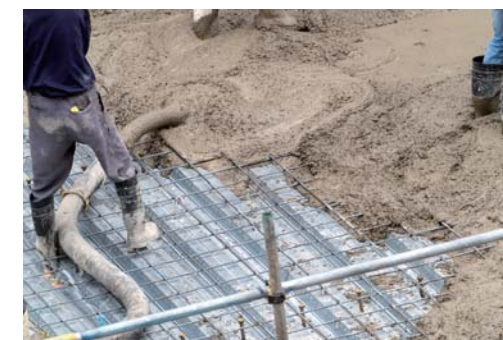
デッキコンクリート打設の削減提案
