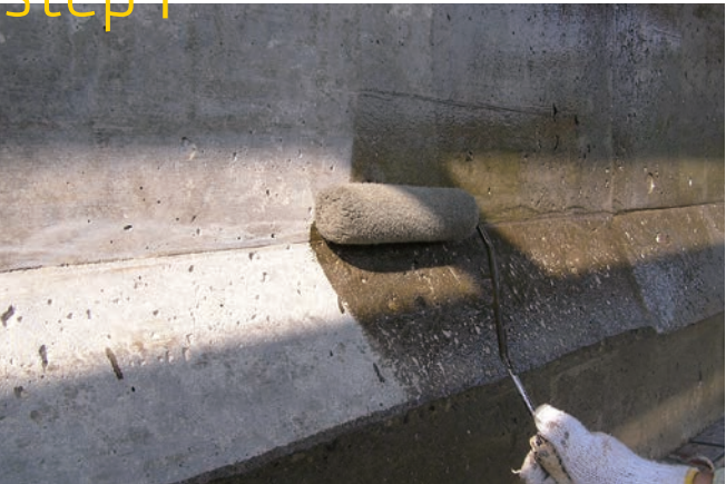
プライマー塗布
