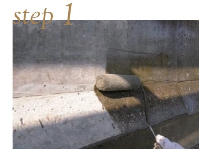
プライマー塗布
