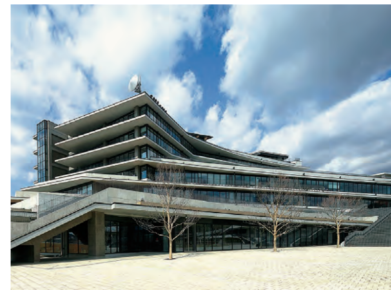
長崎県庁舎 (設計: 日建設計、松林建築設計事務所、池田設計) 2017年 撮影(下): 雁光舎 野田東徳
