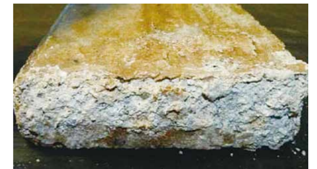
比較用試験体 (防食層未塗布)
