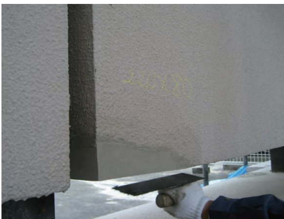
充填材の充填・仕上げ
