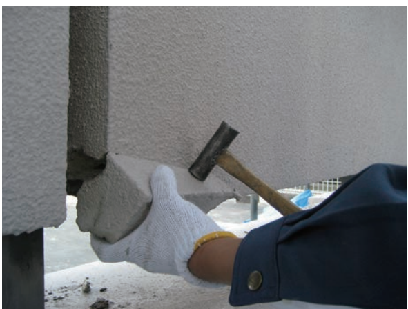
脆弱部はつり・プライマー塗布
