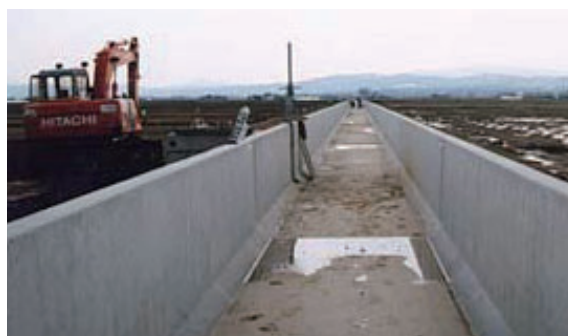
北海道 (国附かん排深川第2地区21工区)
