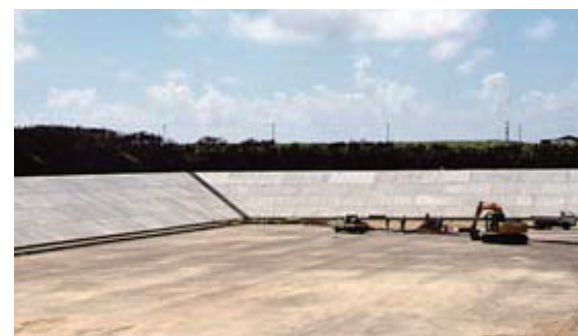
沖縄県 (波照間地区貯水池建設工事)
