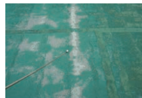
ウレタン塗膜防水 (トップコートの消失)
