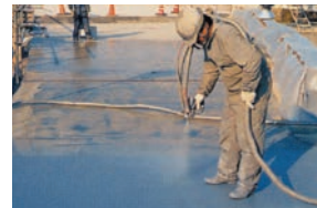
プライマー塗布乾燥後、CVスプレーをコンクリートに直接スプレー施工
