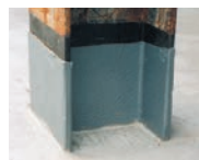
H鋼などの複雑な形状にも施工が可能
