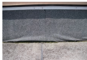
アスファルト防水・押え仕様 (立上り防水層の破断)
