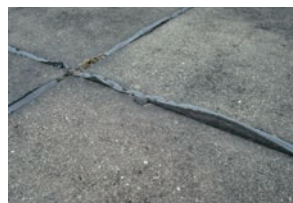
アスファルト防水・押え仕様 (保護層伸縮目地の突出)
