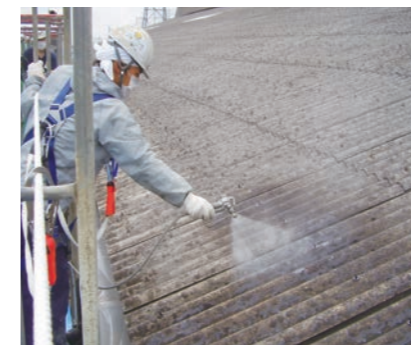
1. プライマー塗布
