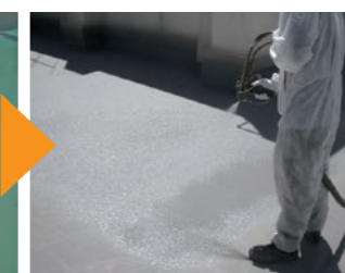
②防水層施工(ウレア層)
