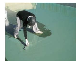
①防水層施工(ウレタン層)
