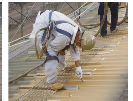
3. ボルト廻りシーリング処理
