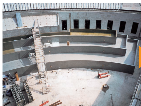
新築 防水施工
