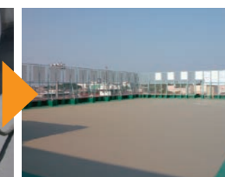
③防水層完成
