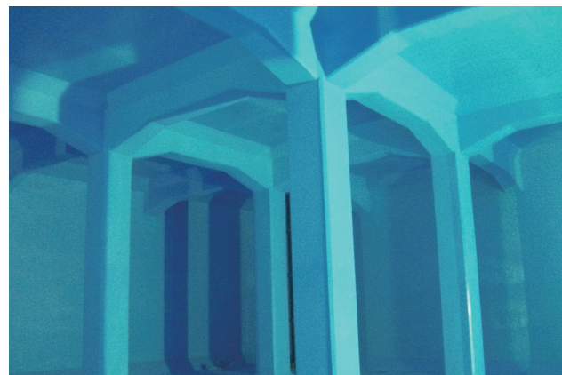
上水施設(配水池)
