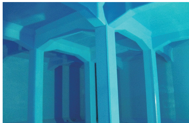
上水施設(配水池)
