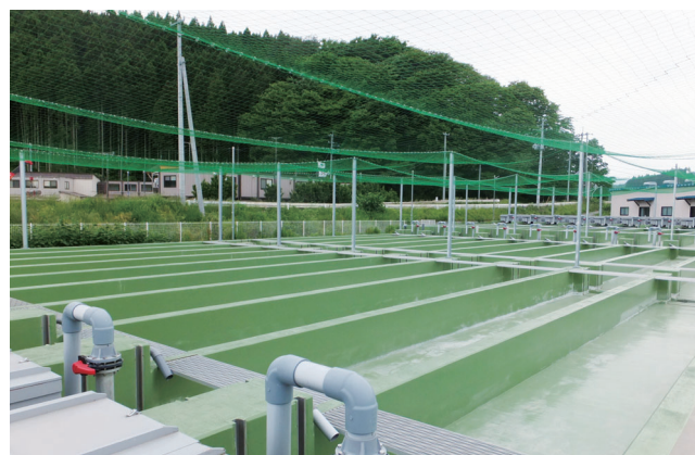
漁業施設(養魚場)
