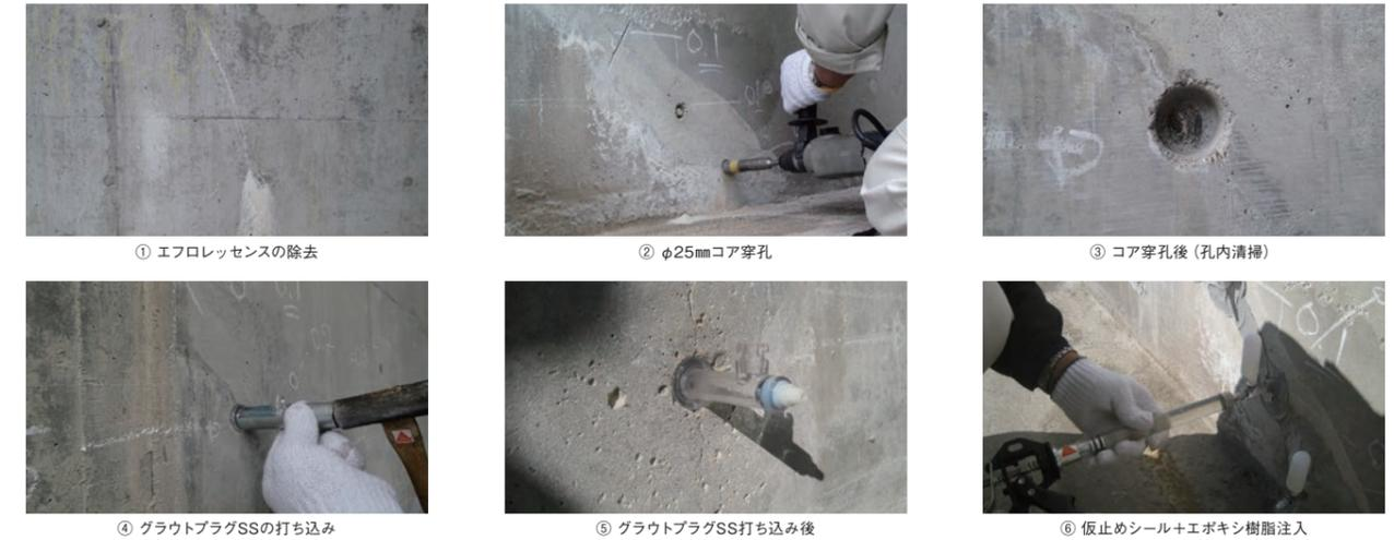
サッシとモルタルの空隙部へφ25mmコアカッターで深さ10～15mm程度穿孔しグラウトプラグSSを打ち込みと仮止めシールを行い隙間へのエポキシ樹脂を注入を行う事も可能となります。
