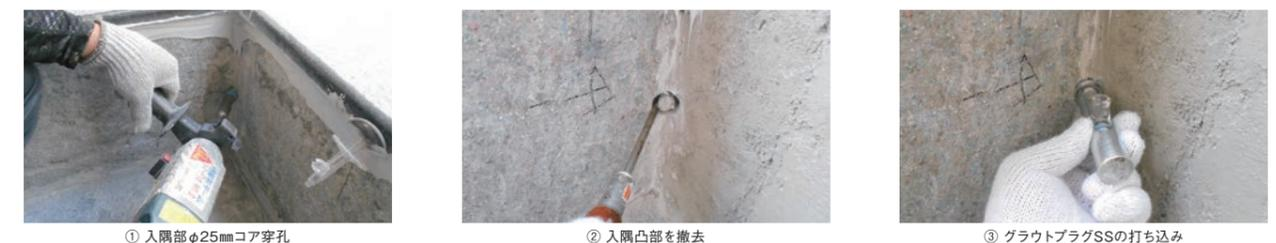
SK グラウトプラグ SS 注入止水工法 使用製品
