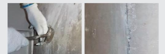
ひび割れ・コールドジョイント（打ち継ぎ）・セパ穴漏水箇所
