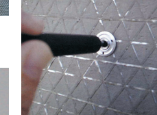
アンカーピン打込み
