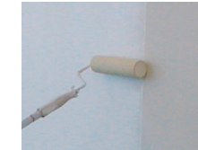
仕上げ材施工
