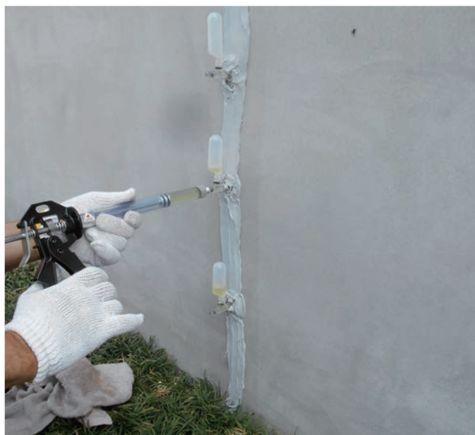
建築構造物 新設 腰壁
