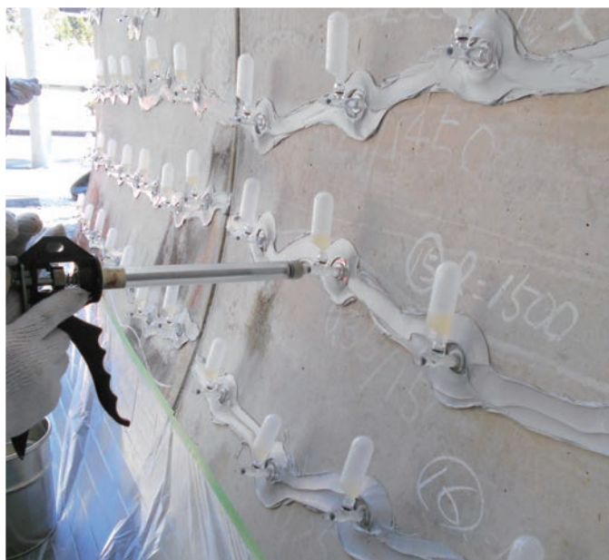
土木構造物 改修 トンネル内壁
