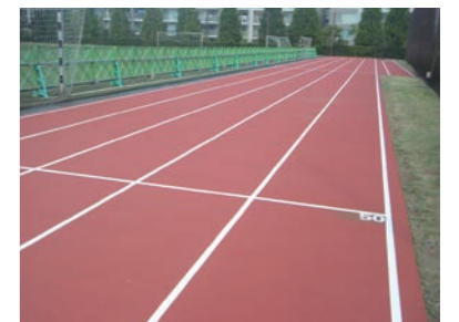
改修工事完了
