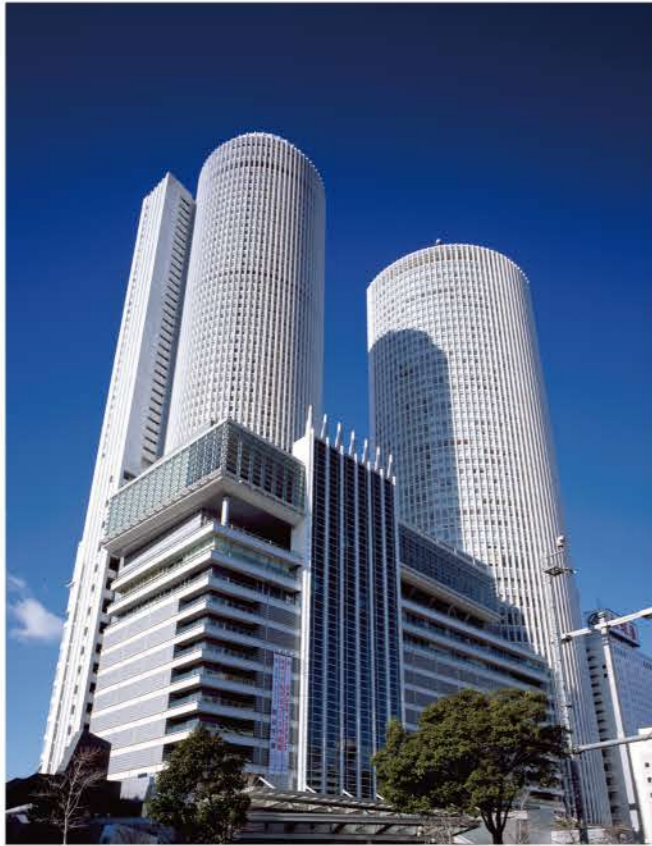
名古屋駅セントラルタワーズ【 sc-MS 2NB / SUPER II 】
