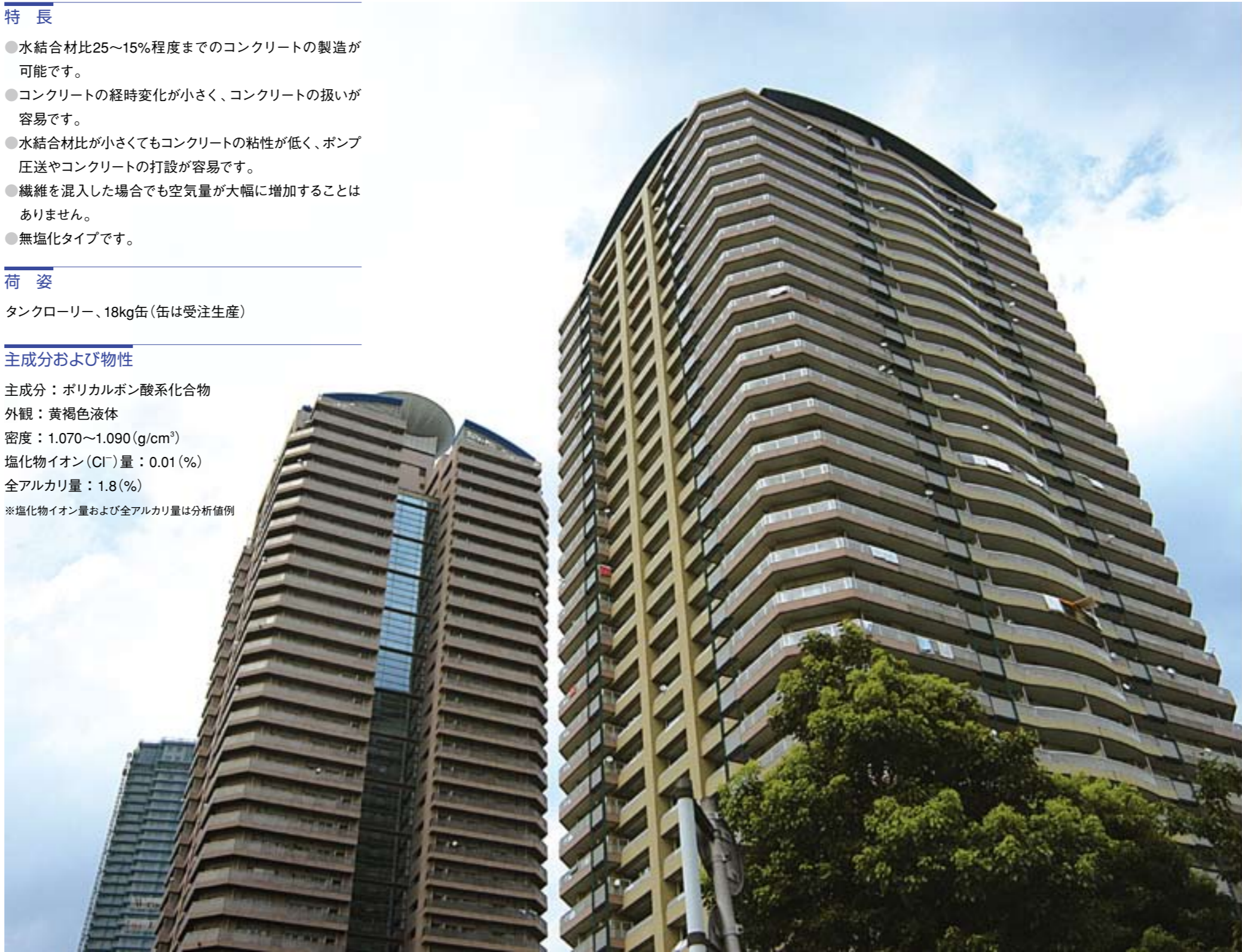
東雲キャナルコート/Wコンフォートタワーズ 東雲キャナルコートは、地区面積16.4ヘクタールに総戸数約6,000戸の住宅と大型商業施設、都市計画公園を含んだビックプロジェクトです。シンボルであるWコンフォートタワーズには、通常のマンションなどに使用されるコンクリートの3~4倍もの強度を持つ超高強度コンクリートが打設されています。このコンクリートには超高強度コンクリート用混和剤シーカメント®1200Nが使用されています。
