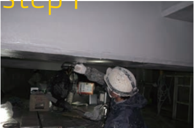
プライマー塗布
