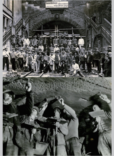
写真上/シュトゥットガルト「シュワブ・トンネル」建設(1894年~1896年) 写真下/石職人が困難に直面したNY「ハドソン・トンネル」の防水工事(1934年)
