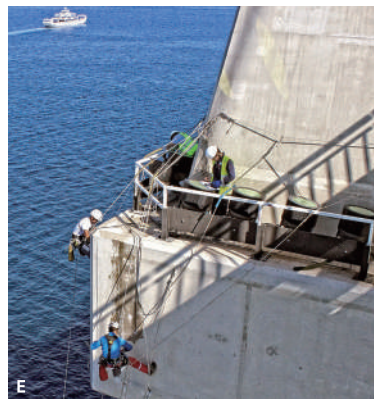
D. 斜張橋「クイーンズフェリー・クロッシング(主塔3本)」の補修工事 E. シーカの疎水性含浸材による橋桁コンクリートの修復 F. シーカの屋根材・床材が採用された「ロサンゼルス国際空港」建設工事
