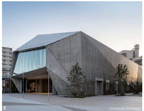
D. アリゾナ州立大学のアリーナの屋根ソリューション E. コンクリート打ち放しのデザインに調和する 「なでしこ芸術文化センター」のウレタン防水屋根
