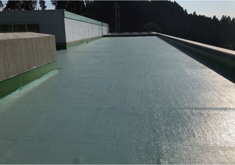
ウレタン塗膜防水改修例
