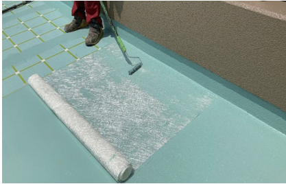
タフレックスとタフマットによる施工
