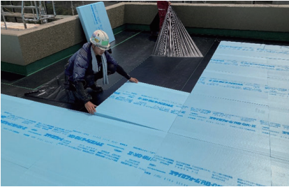
DF・BBシートによる断熱材の固定
