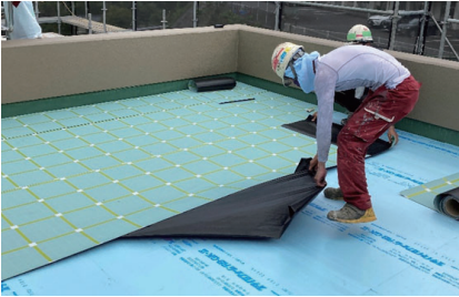
通気緩衝シート張り
