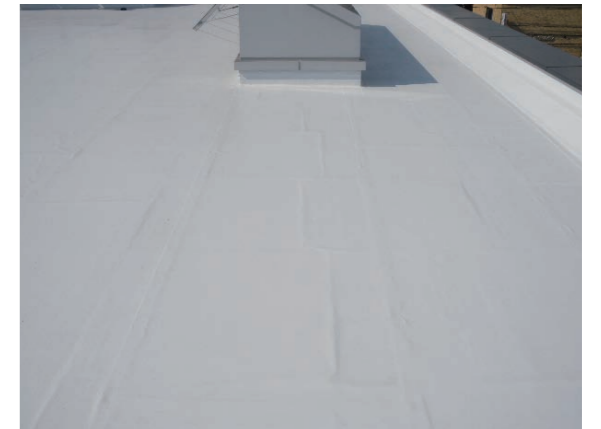
断熱材の段差
