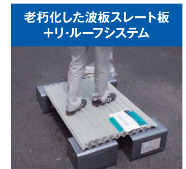
老朽化した波板スレート板+リ・ルーフシステム
