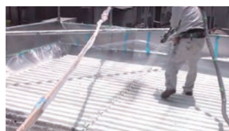
断熱補強層 施工 (SGフォーム吹付け)
