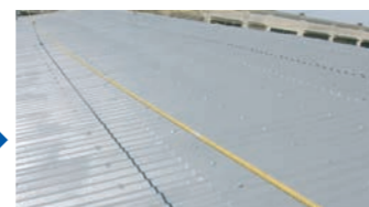
トップコート塗布後完成
