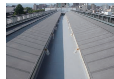
谷樋部「SPRF」+金属屋根下「SPX-2」
