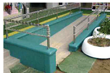
安全対策施設
