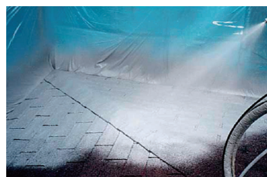
シングル屋根改修
