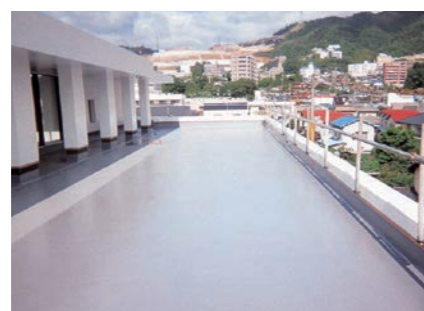
防水施工完了
