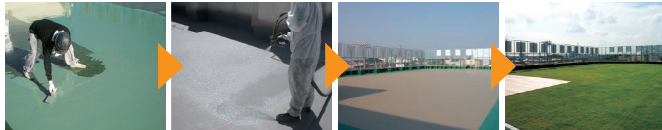
①防水層施工(ウレタン層) ②防水層施工(ウレア層) ③防水層完成 ④植栽完成
