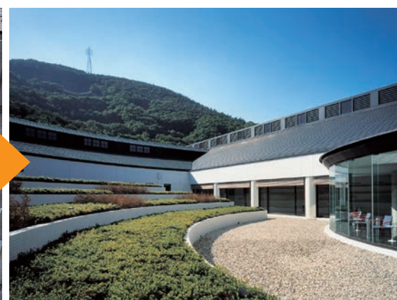
新築 植栽完了
