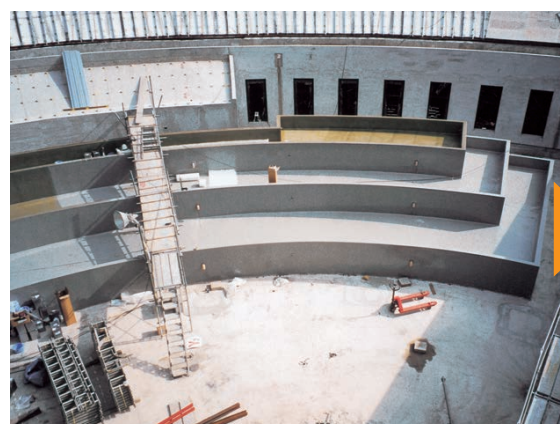
新築 防水施工
