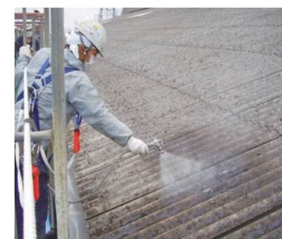
1. プライマー塗布
