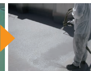
②防水層施工(ウレア層)
