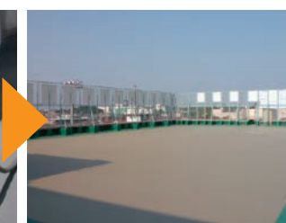
③防水層完成
