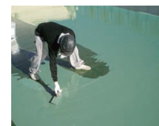
①防水層施工(ウレタン層)
