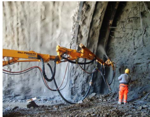
トンネル内施工状況
