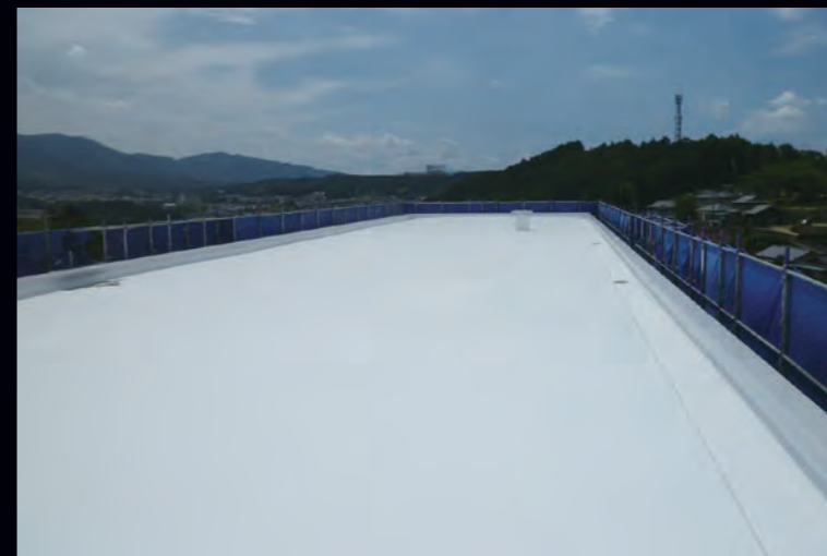
場 所：岐阜県 施工面積：1,300㎡
