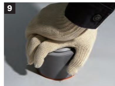
9 専用圧着治具で約8~10秒押える
