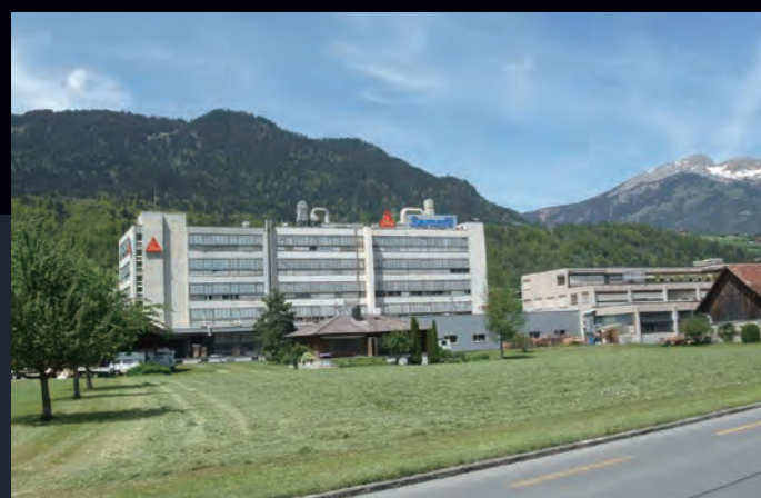
サーネン工場
