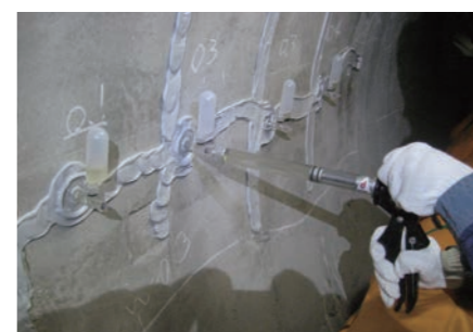
地下ビットひび割れ注入
