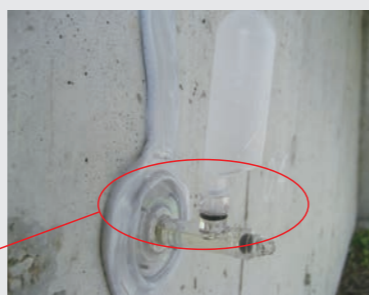
注入後、プラグからDFポンプを外す際は、必ずバックレバーを押し、少しピストンロッドを引いた後に、外してください。
