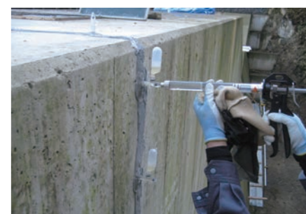
砂防堰堤ひび割れ注入
