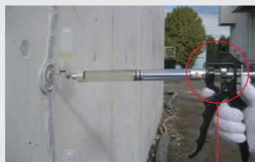
注入後、プラグからDFポンプを外す際は、必ずバックレバーを押し、少しピストンロッドを引いた後に、外してください。
