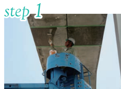
シーカガード®ワンガードクリア プライマー塗布
