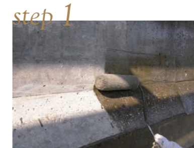
プライマー塗布
