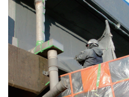
●レジテクト100(R1)吹付け
