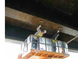
●プライマー塗布
