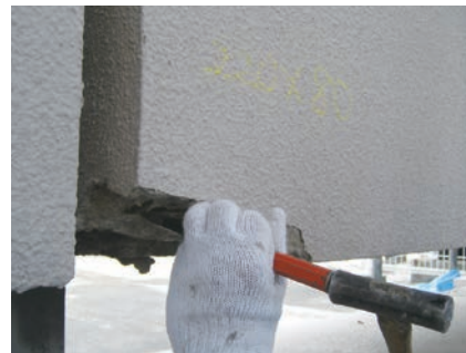
3. 脆弱部の撤去
