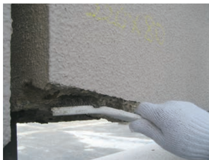
4. 鉄筋錆の撤去
