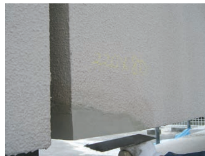
6. プライマー塗布、SK モルタル充填仕上げ
