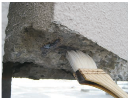
5. SK 錆止め剤の塗布
