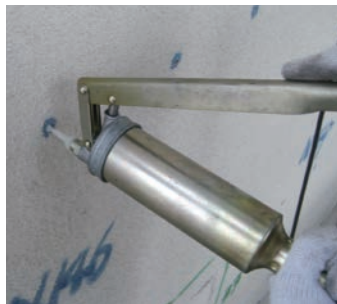
エポキシ樹脂注入作業
