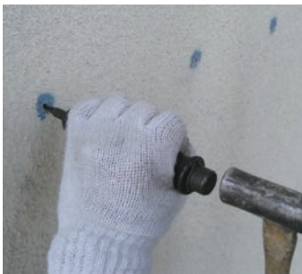
グラウトピン挿入後開脚固定作業
