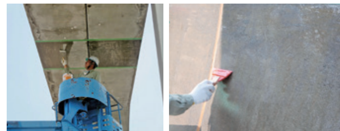
ステップ 1) ワンガードクリアプライマー塗布 ステップ 2) ワンガードクリア塗布
