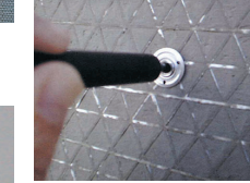
アンカーピン打込み
