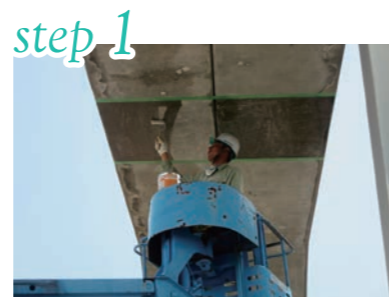
ワンガードクリアプライマー塗布
