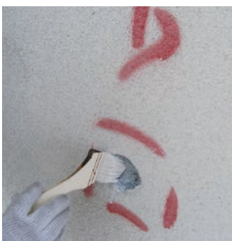
DF 浸透性プライマー塗布作業
