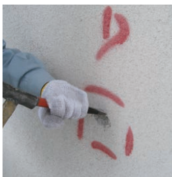
脆弱部のハツリ作業
