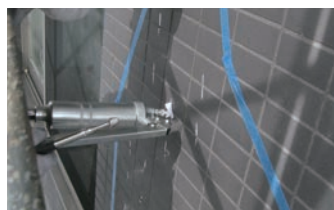
タイル張付けモルタルと躯体間の浮き部注入
