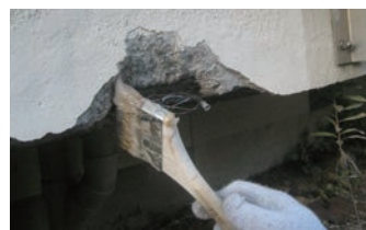
欠損部のプライマー用途 (SK モルタル)
