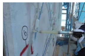
ひび割れ注入
