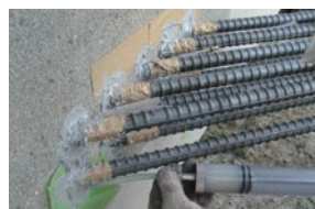
アンカーボルト定着
