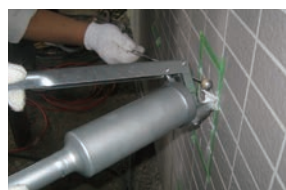
外壁タイル張りの浮き部注入
