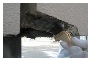
露筋欠損部のプライマー用
